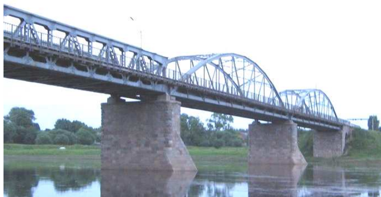
Рисунок 18. – Мост через реку Дисна
