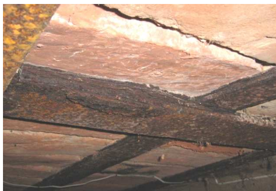
Рисунок 8. – Сквозная коррозия элементов из металлопроката
