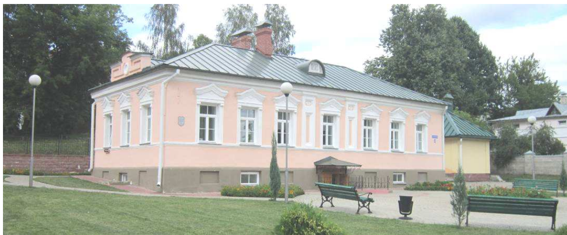
Рисунок 16. – Внешний вид здания и прилегающей территории после выполненных восстановительных работ (2015 г.)
