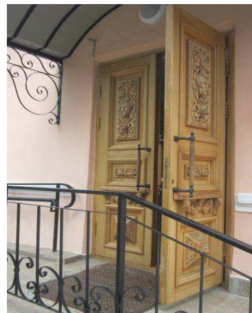
Рисунок 15. – Восстановленные резные деревянные двери
