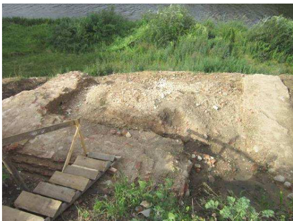
Рисунок 13. – Фундамент Северной башни (2016 г.)
