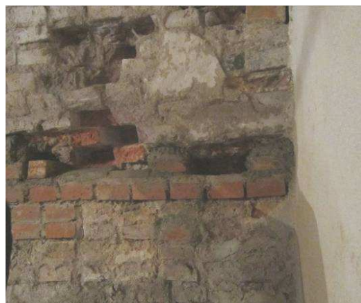
Рисунок 12. – Восстановление кирпичной кладки свода на 1-м этаже Южной башни
