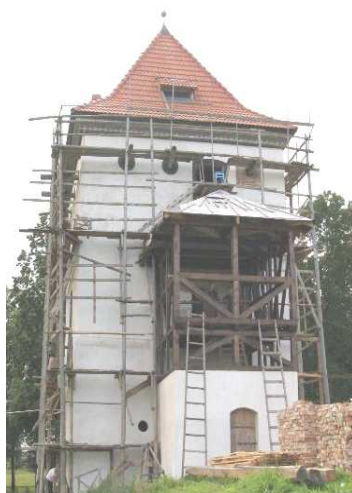
Рисунок 7. – Южная башня, восстановительные работы (2009 г.)
