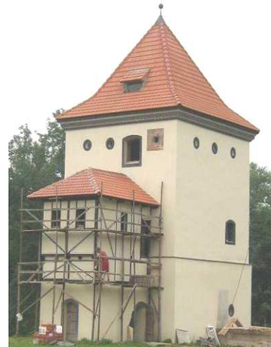
Рисунок 8. – Южная башня, отделочные работы (2010 г.)
