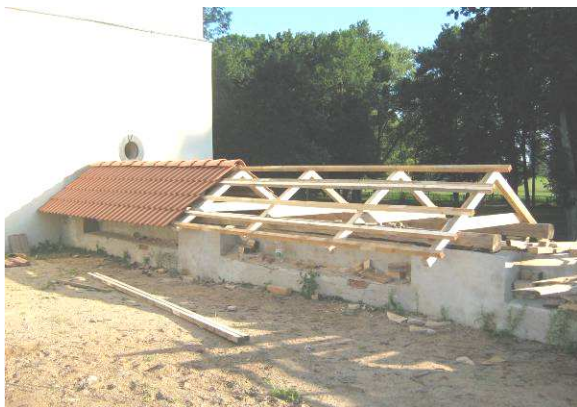
Рисунок 17. – Стропильная система на первых двух пролетах стены у Южной башни (2010 г.)
