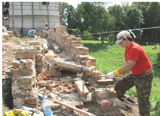
Рисунок 16. – Кладочные работы на оборонительной стене (2009 г.)
