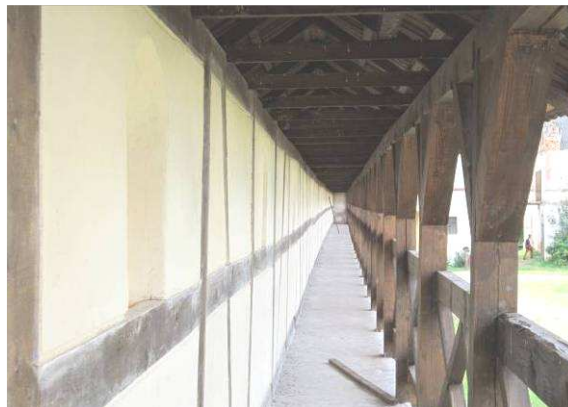
Рисунок 18. – Галерея оборонительной стены, вид от Южной башни (2016 г.)
