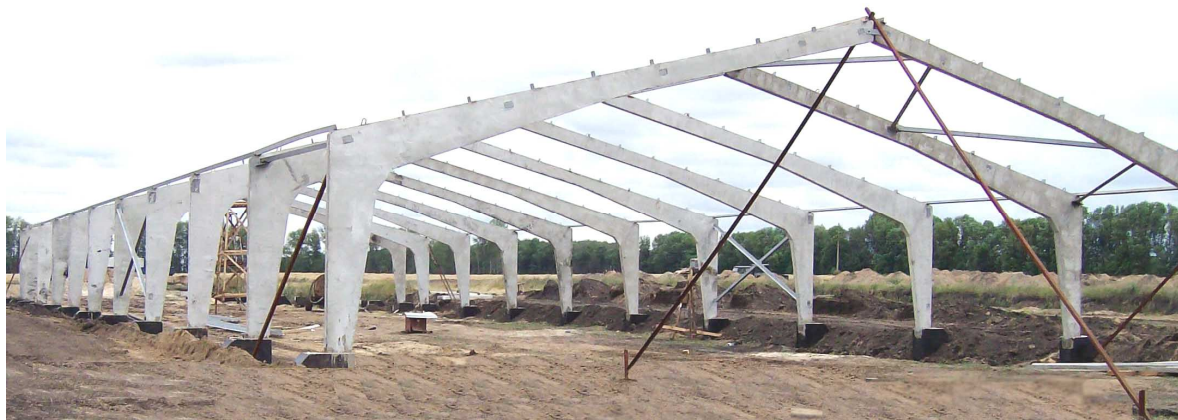
Рисунок 1. – Распорное сооружение, состоящее из полурам
