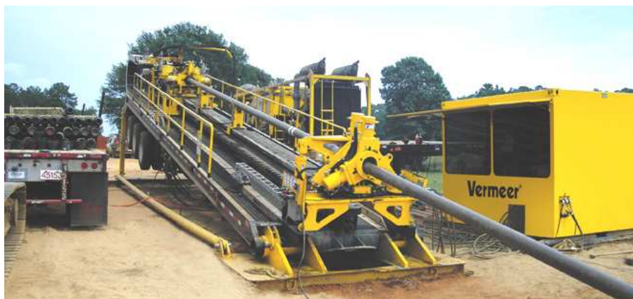
Рисунок 1. – Установка наклонно направленного бурения
