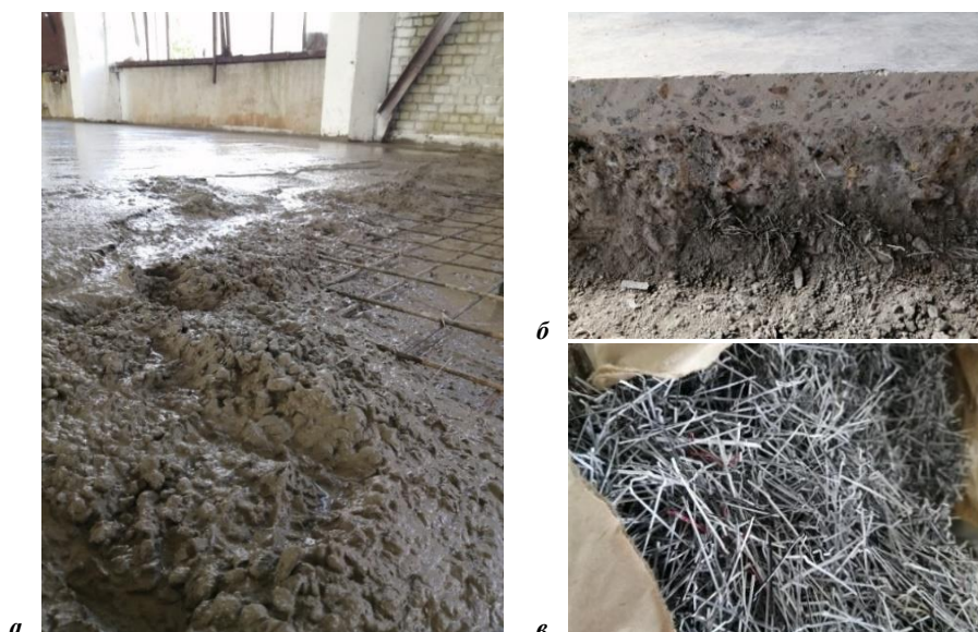
a – фибробетонная смесь при укладке; б – внешний вид стыка фибробетонного слоя пола; в – фибра из листовой стали анкерная (ФЛА-0,9-50)
