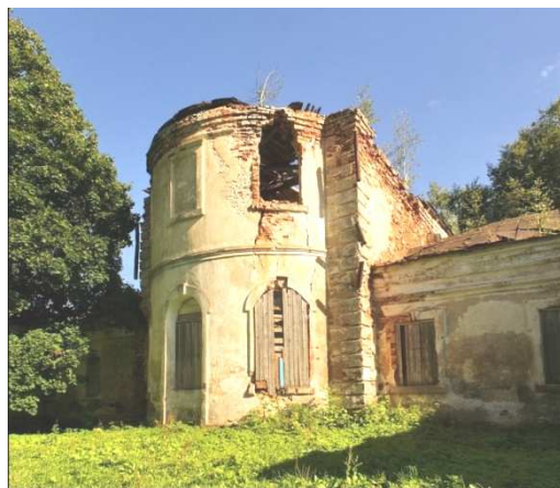
Рисунок 3. – Разрушающиеся части здания: эркер дворового фасада (а); портик главного входа (б)
