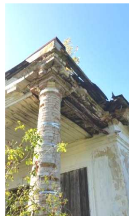
Рисунок 3. – Разрушающиеся части здания: эркер дворового фасада (а); портик главного входа (б)
