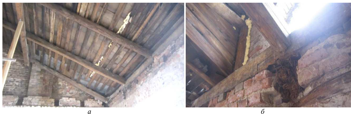
Рисунок 11. – Поражение гнилью обрешетки (а) и мауэрлата (б)
