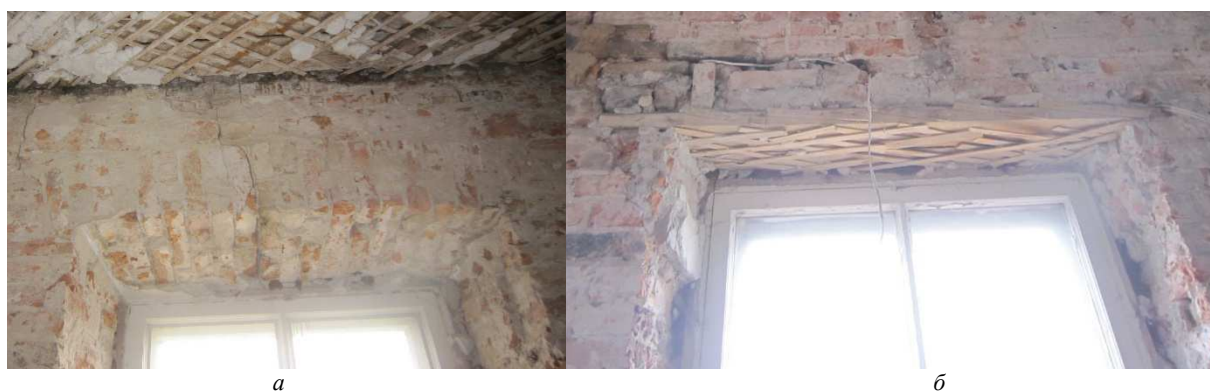
a – кирпичные клинчатые; б – деревянные Рисунок 6. – Перемычки
