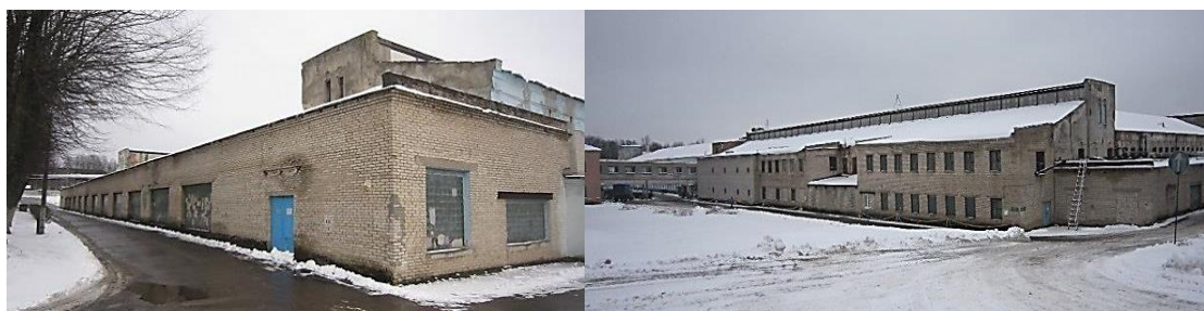
Рисунок 3. – Общие виды здания ПТКИ
