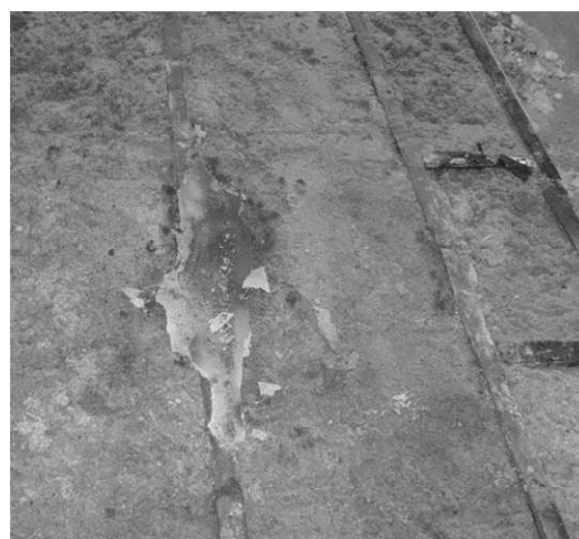
Рис. 5. Образец при испытании 45 минут с защитными гипсокартонными листами и стеклотканью после демонтажа обшивки
