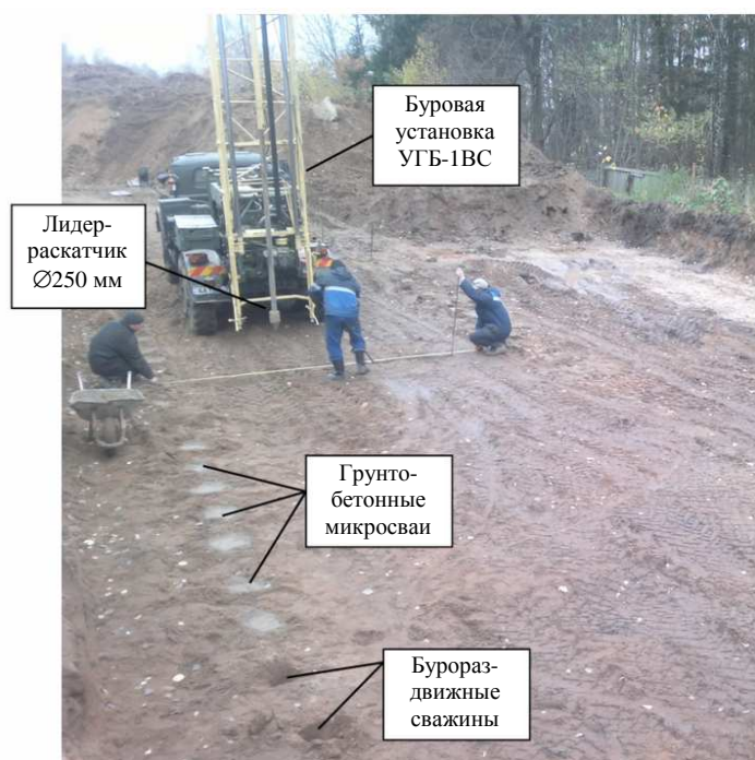
Рисунок 5 – Процесс изготовления армозащитных элементов на строительной площадке здания
