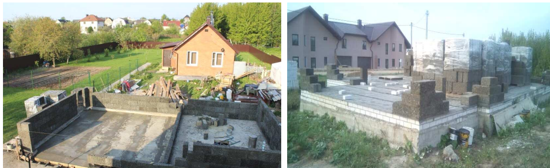
Рисунок 2 – Строительство индивидуальных жилых домов в Минском районе из модифицированного арболита (ООО «ЭкономЭнергоРесурс», г. Молодечно)
