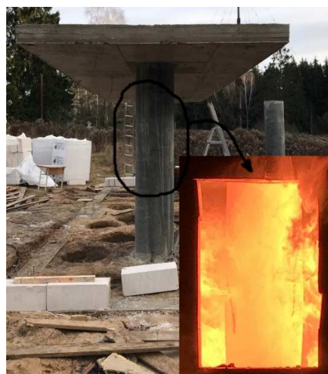
а – схематическое изображение; б – вид колонны с торцевой стороны фрагмента, в т.ч. при пожаре. Рисунок 2. – Механизм разрушения центрифугированной железобетонной колонны при пожаре
