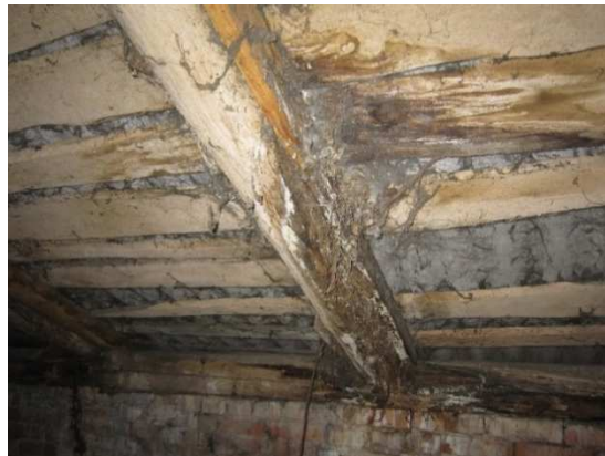
Рисунок 16. – Разрушение стропильных ног
