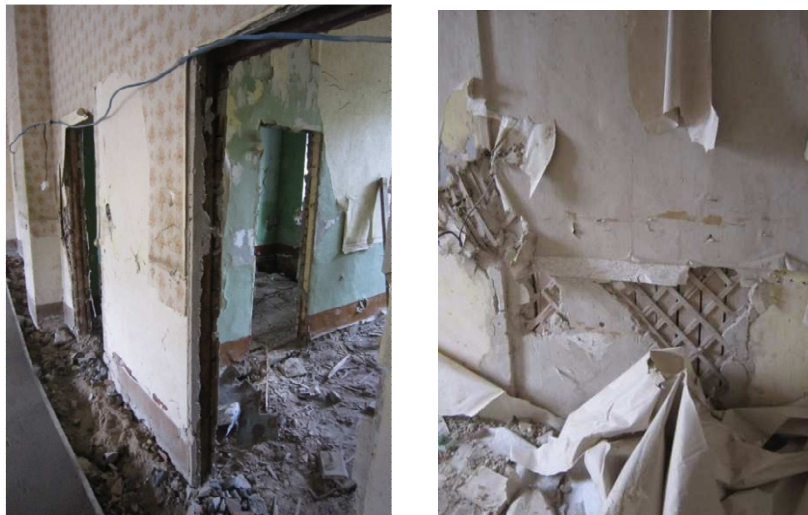
Рисунок 11. – Техническое состояние деревянных перегородок
