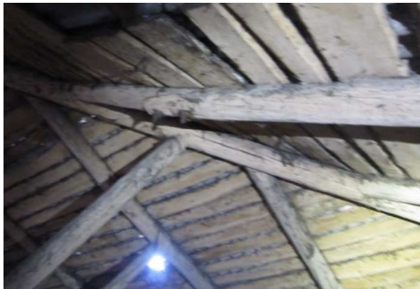
Рисунок 16. – Разрушение стропильных ног
