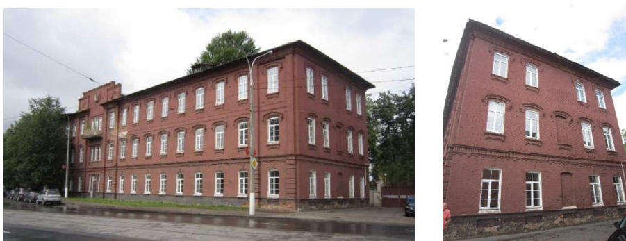
Рисунок 2 – Общие виды здания
