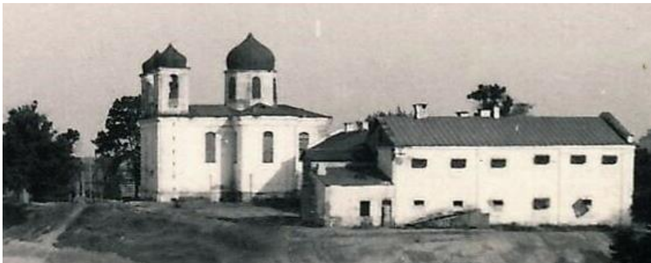
Рисунок 8. – Бывший бернардинский монастырь, фото 30-х гг. XX в., на месте разбитого торца Малой части – одноэтажная пристройка с отдельным входом, посаженная на первоначальные стены здания
