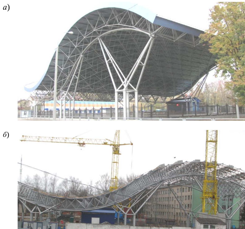
Рис. 3. Покрытие ледового катка в Гомеле: а – общий вид; б – проведение натурных испытаний
