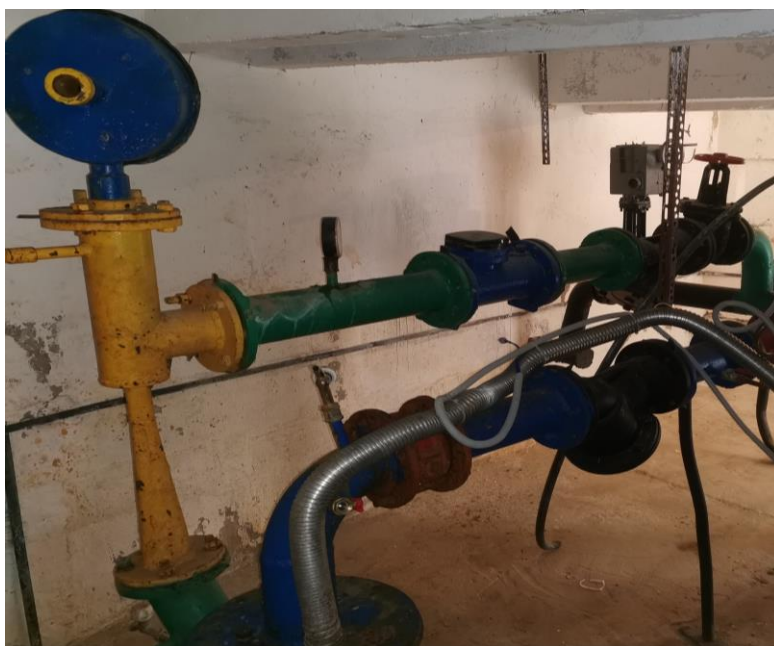
Рисунок 5. – Эжектор скважины
