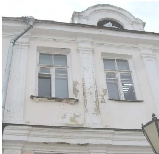
**Рисунок 5. – Местные участки, имеющие повреждения отделочного штукатурного слоя наружной стены по оси А**
