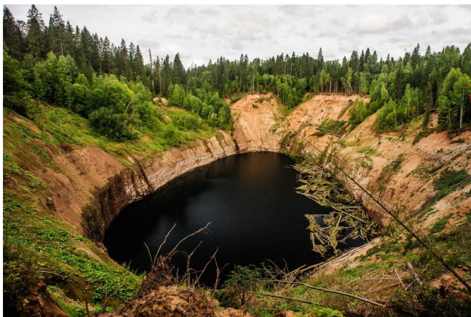
Рисунок 2. – Вид провала поверхности земли в районе Березниковского рудника БКРУ-3
