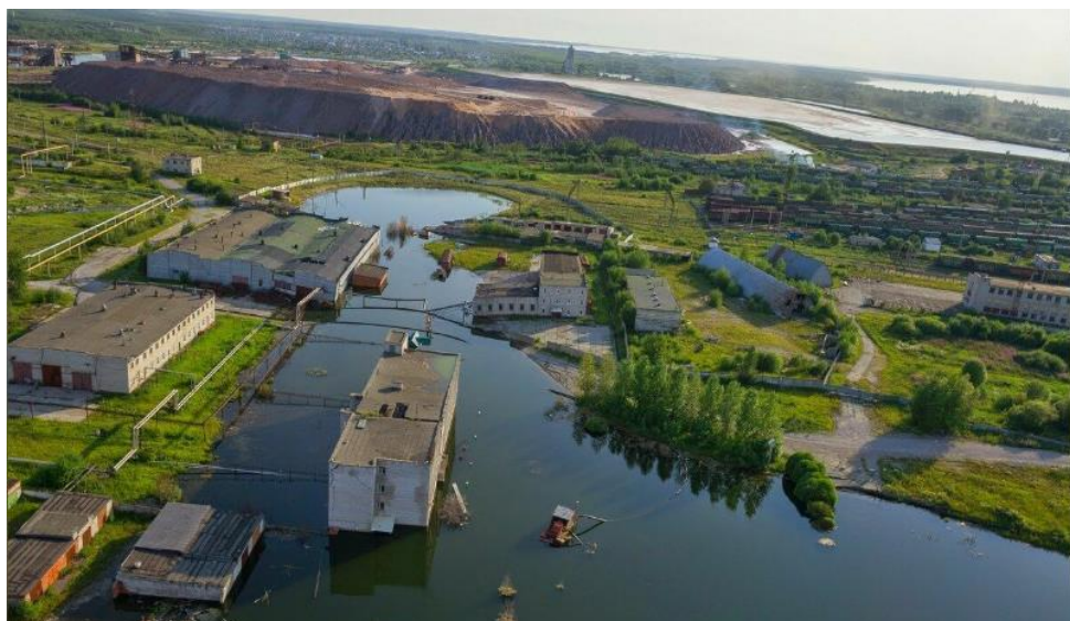
Рисунок 1. – Вид Березниковского рудника БКРУ-1 после затопления
