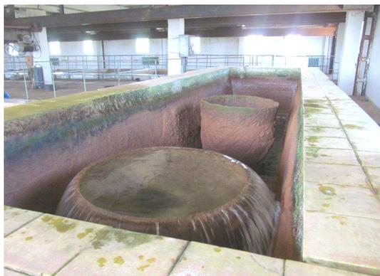
Рисунок 1 – Камера аэрации
