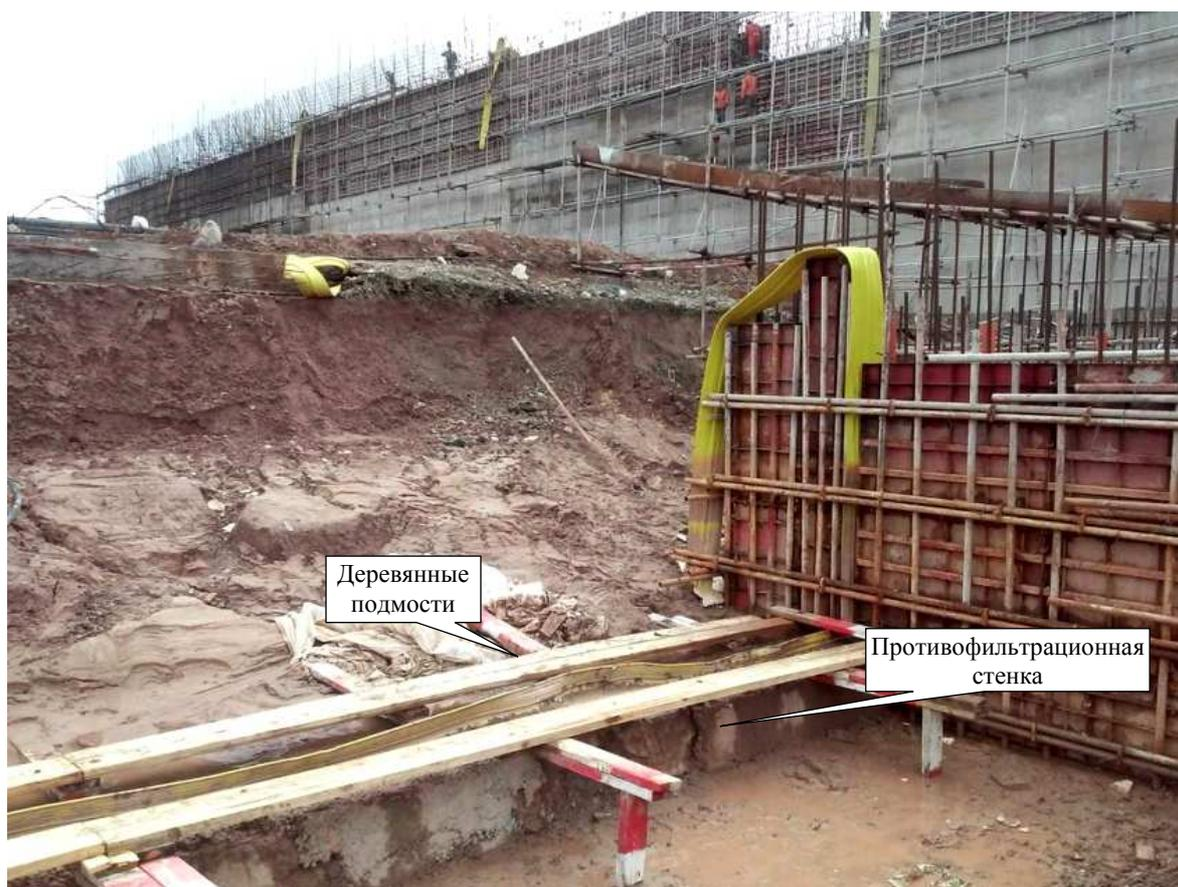
Рисунок 1 – Противofильтрационная стенка и прилегающая территория
