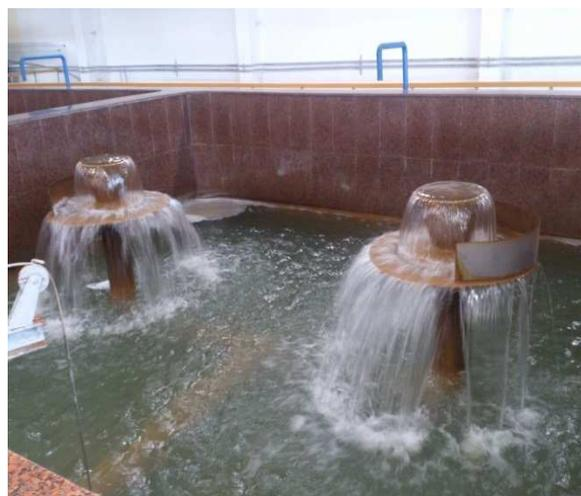
Рисунок 12 – Излив воды в корпусе фильтра
