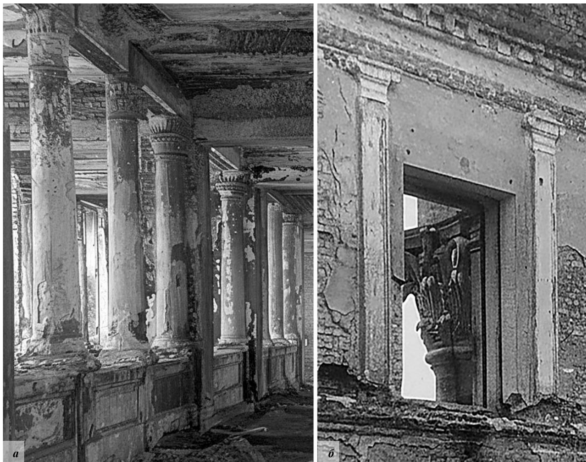
а – калоны вестыбюля пры актавай зале: камбінацыя дарычнай і егіпецкай капітэлі з артаментальнымі паліхромнымі дэкаратыўнымі размалёўкамі; б – геаметрычна стылізаваныя іанічныя капітэлі актавай залы
