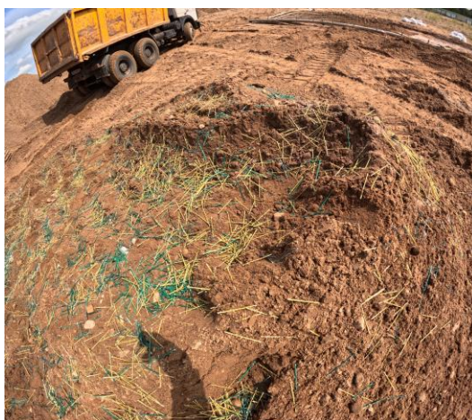
Рисунок 3. – Возведение искусственного основания с применением фибры (фото предоставлено аспирантом кафедры «Геотехника и строительная механика» Медведевым Л.Ю.)
