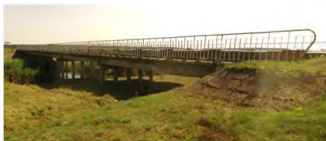
Общий вид транспортного сооружения
