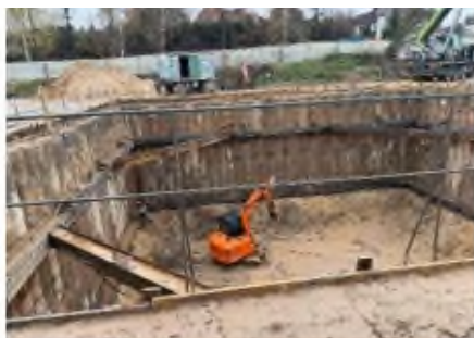
Общий вид ограждающих конструкций котлована
