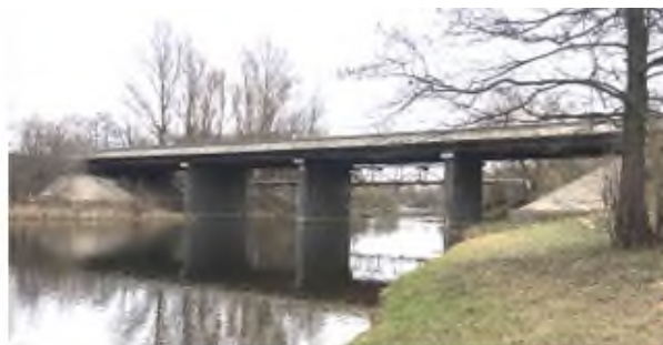
Общий вид транспортного сооружения
