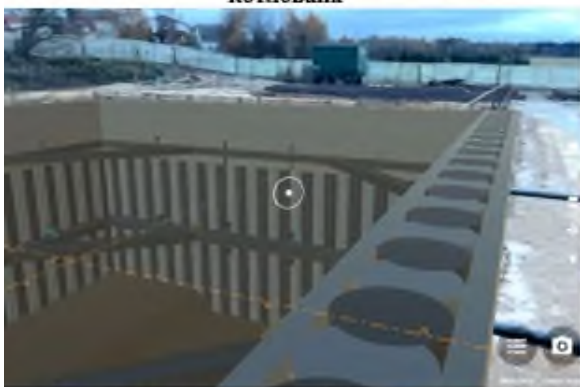
Дополненная реальность (AR) ограждающих конструкций котлована
