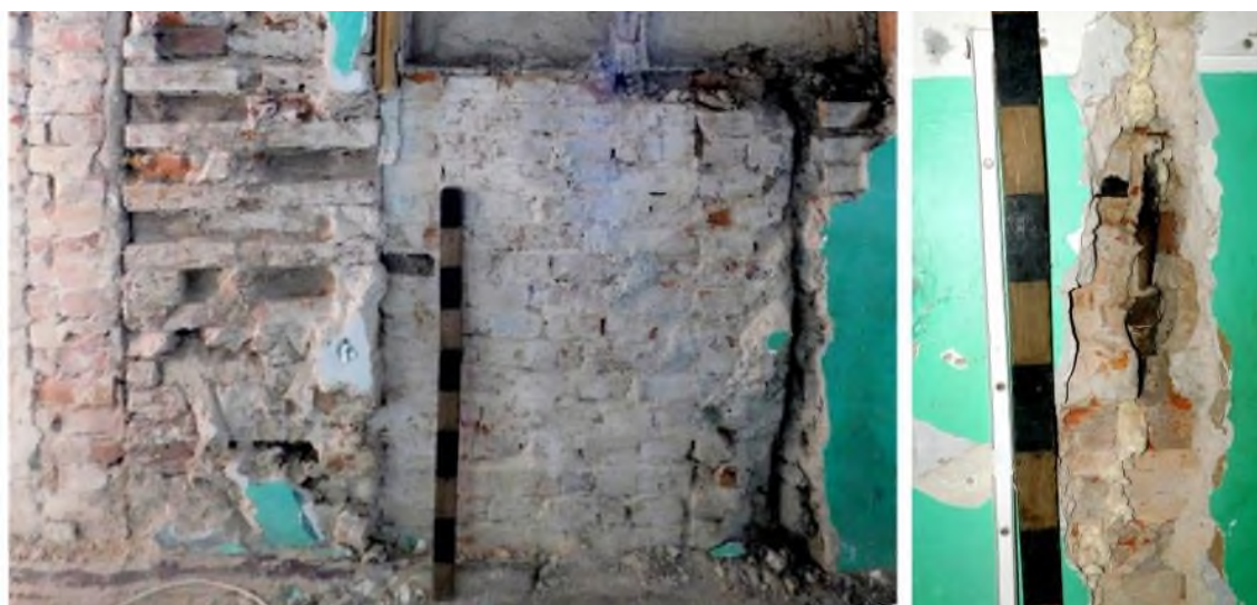
1. – выложенная каменщиками кирпичная штроба для соединения поперечной кладки на западной стене, рядом – закладка дверного проёма возле ниши электрошита; 2. – фиксация металлического тяжа по восточной стене на уровне междуэтажной площадки
