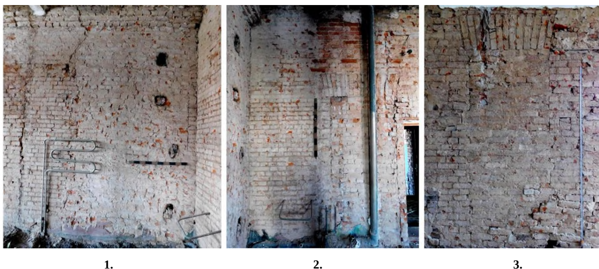
1. – следы замурованного прохода в северной стене; 2. – следы дверных проёмов и ниш в северной части восточной стены; 3. – сохранившийся замурованный дверной проём в южной стене и замурованное гнездо под леса
