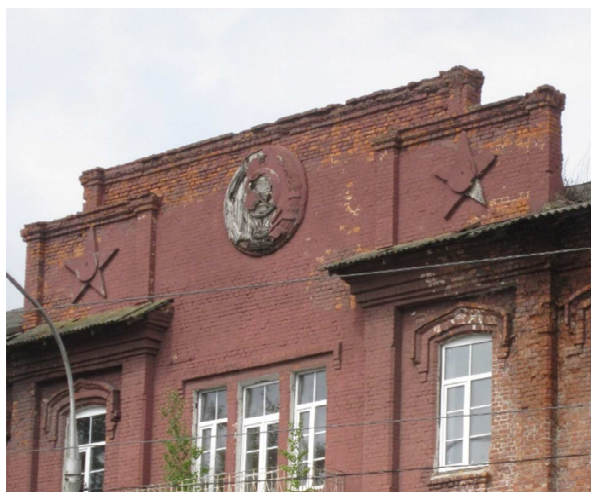
Рисунок 10. – Повреждение кирпичной кладки фронтона над главным входом по оси А в осях 7–12
