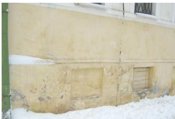
Рисунок 4. – Разрушение штукатурного слоя цокольной части стены по оси «А»
