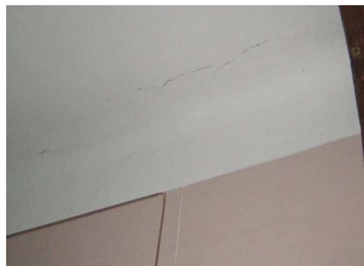
Рисунок 9. – Трещины в местах примыкания потолка к наружной стене по оси «А»
