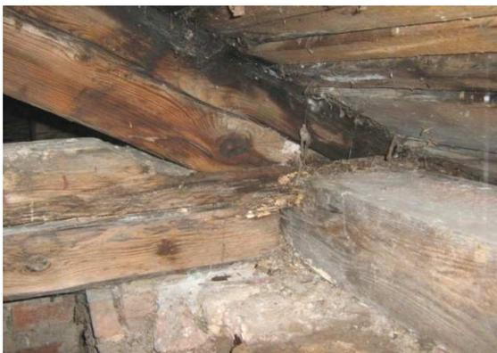
Рисунок 10. – Загнивание и плесень на стропильной ноге в опорном узле по оси «Б»
