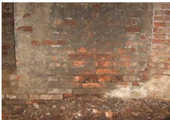
Рисунок 6. – Разрушение кладки наружной стены подвала по оси «4»
