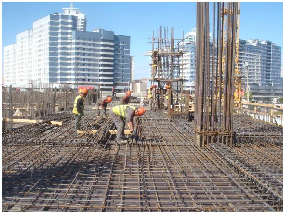
Рисунок 4. – Поэлементный монтаж арматурного каркаса колонны
