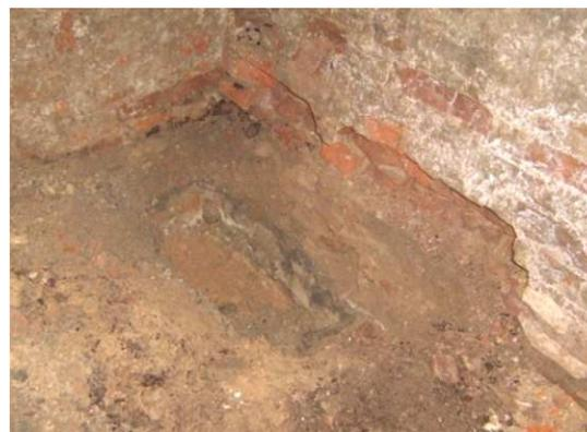
Рисунок 11. – Разрушение внутренней версты кладки фундамента на пересечении осей «Б» и «4»
