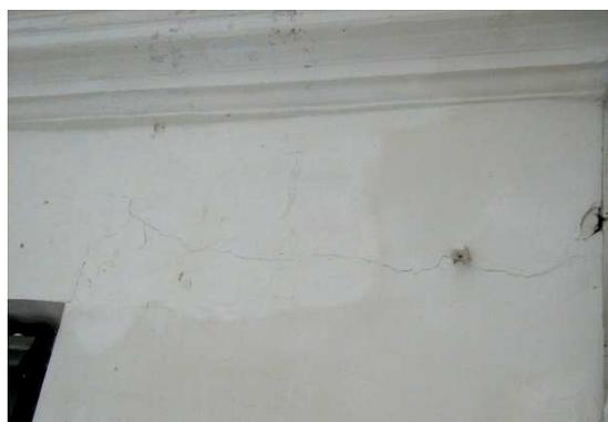
Рисунок 5. – Трещина по штукатурному слою стены по оси «Б» на пересечении с осью «1»
