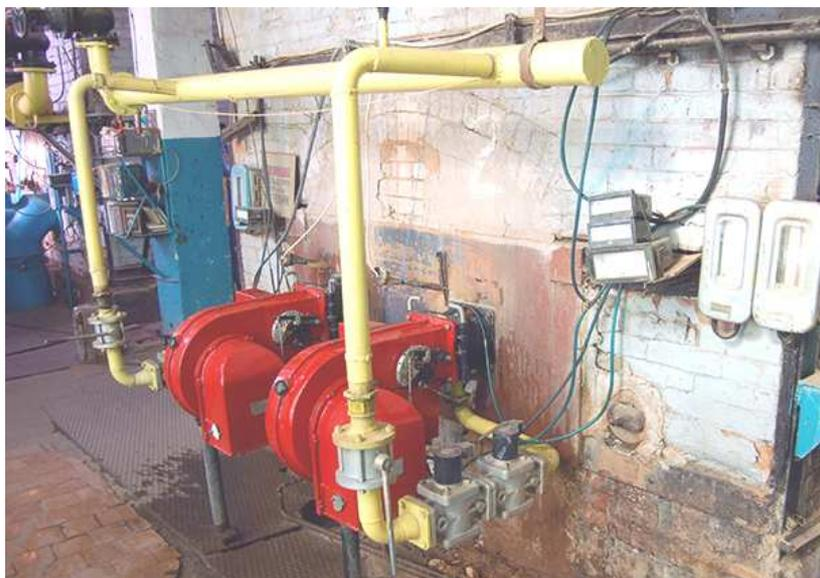
Рисунок 1. – Котел ДКВр-6,5-13 ГМ, оборудованный для сжигания природного газа
