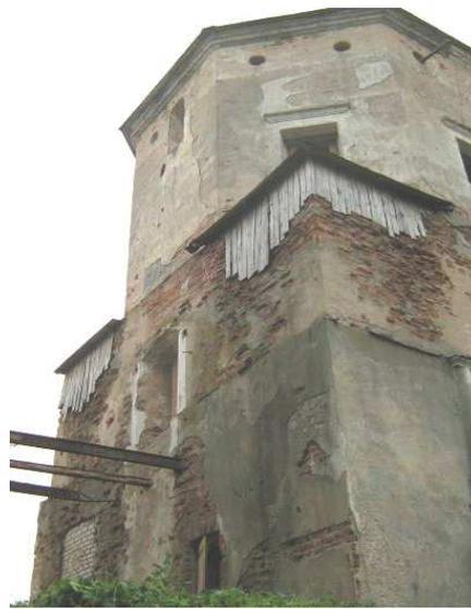
Рисунок 3. – Разрушение кирпичной кладки башни (2008 г.)
