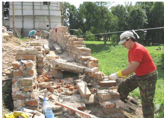
Рисунок 16. – Кладочные работы на оборонительной стене (2009 г.)
