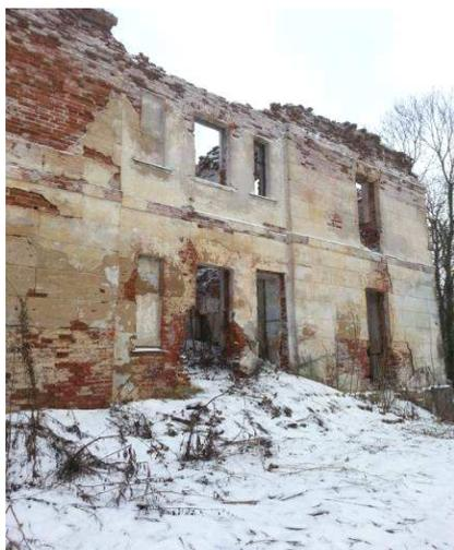
Рисунок 4. – Разрушение наружной стены торцевой части здания
