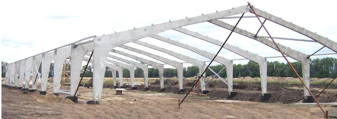
Рисунок 1. – Распорное сооружение, состоящее из полурам
