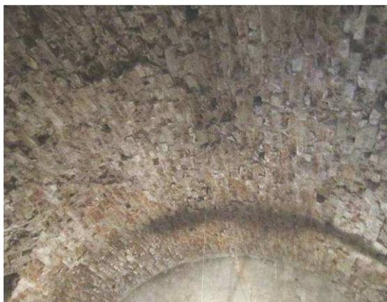
Рисунок 9. – Разрушение кладки свода 1-го этажа
