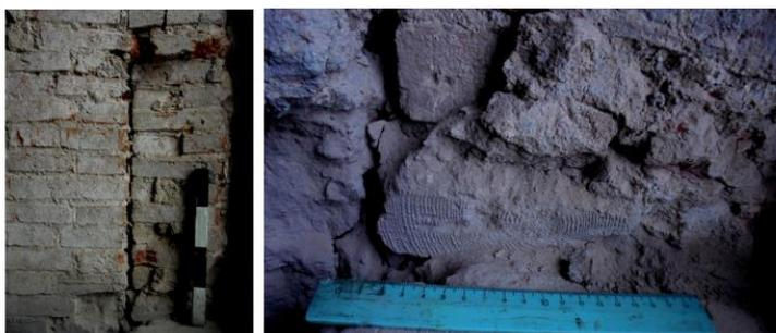
Рисунок 7. – Стык продольной стены и перевязка его в районе оконного проема, отпечаток доски первоначального подоконника на растворе
