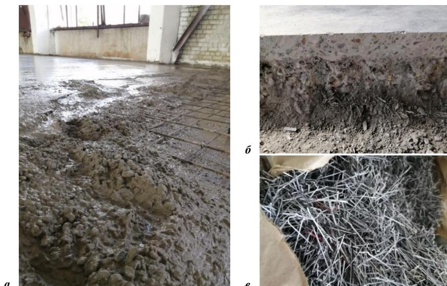
*a* – фибробетонная смесь при укладке; *б* – внешний вид стыка фибробетонного слоя пола;
