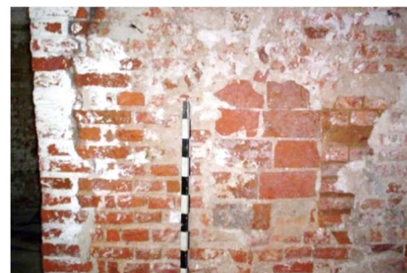
Рисунок 5. – Фрагмент замурованной ниши предпечья пекарской печи
