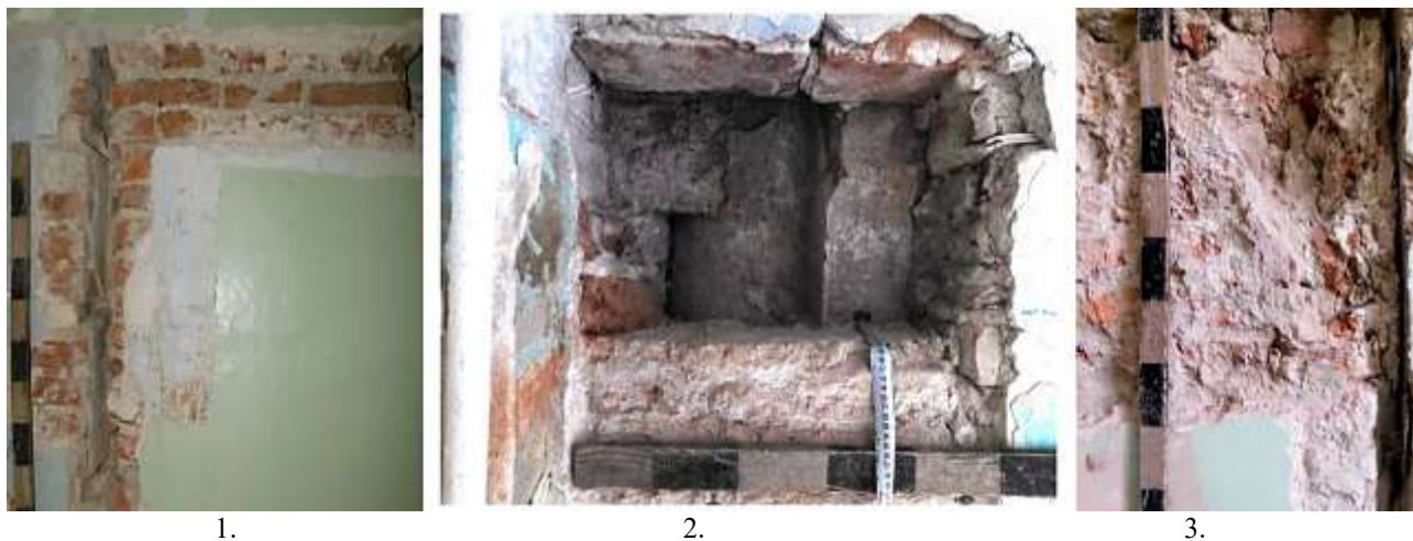
1. – русты на пилястре; 2.–замурованный округлый юго-восточный угол колокольни (вид со стороны корпуса); 3. – остатки откоса и пяты от окна восточного нефа (вид со стороны пристройки)
