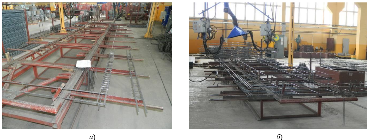
Рис. 4. Процесс сварки арматурного каркаса в цехе: а – раскладка составляющих элементов арматурного блока; б – общий вид готового арматурного блока
