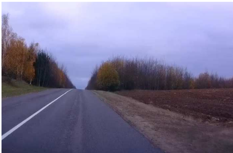
Рисунок 2. – Неудовлетворительное состояние обочины может способствовать ДТП
