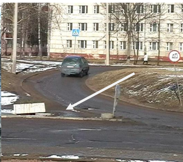
Рис. 3. Съезд со скоростной дороги на улице Блохина
