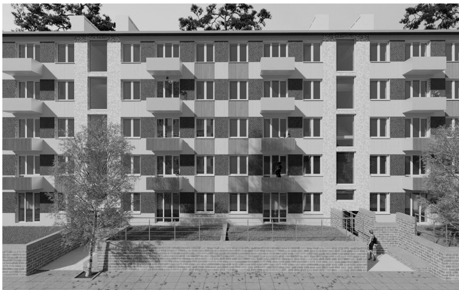
Рисунок 3. Фрагмент фасада типового жилого дома серии 1-335 после реконструкции
