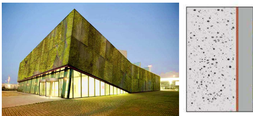
Рисунок 2. – Навесная многослойная панель
