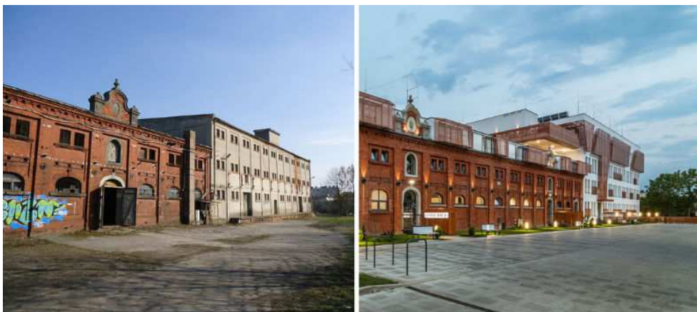
Рисунок 4. – Реконструкция зданий фермы под центр для пожилых людей в Лещно, Польша. Вид до и после реконструкции
