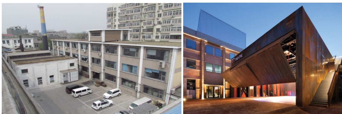
Рисунок 3. – Фабрика печати в Пекине, КНР. Вид до и после реконструкции
