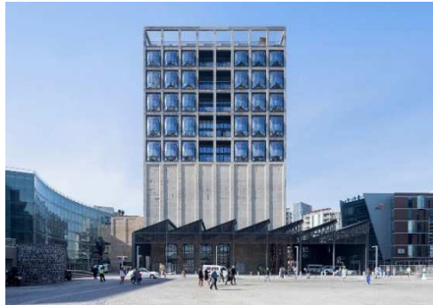
Рисунок 5. – Отделка фасада здания бывшего зернового бункера окнами-панелями в г. Кейптаун, ЮАР (арх. Т. Хетервик)
