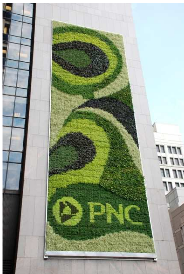
Рисунок 2. – Модульная система из контейнеров. One PNC Plaza в Питтсбурге
