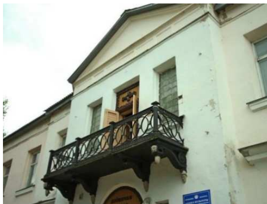
Рисунок 2. – Балкон второго этажа
