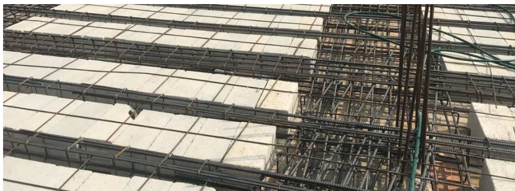
Рисунок 5. – Пример устройства сборно-монолитных перекрытий в Ливане
