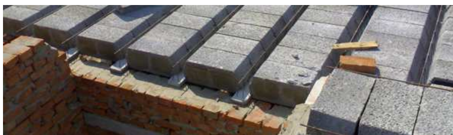
Рисунок 7. – Пример устройства сборно-монолитных перекрытий в Беларуси
