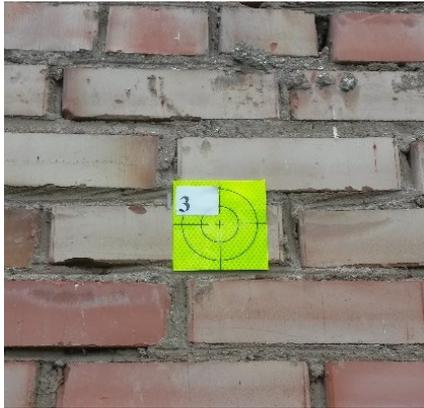
Рисунок 1. – Марка, закрепленная на стене
