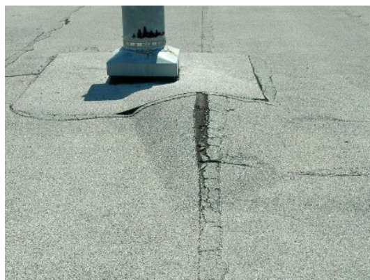
Рисунок 3. – Вздутие кровельного ковра с нарушением герметичности
